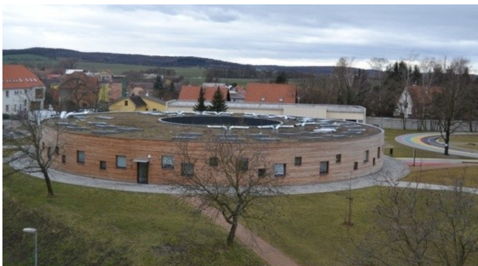
Obrázek 88 - ZŠ Libeznice - exteriér (vlastní zdroj)
