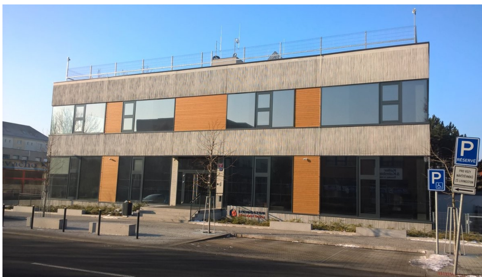
Obrázek 73 – ZŠ Livingston – exteriér (Základní škola Livingston)
