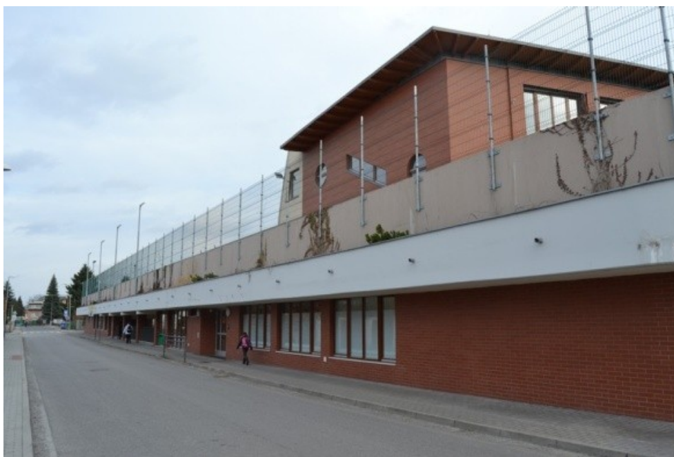
Obrázek 89 – ZŠ Povážská – exteriér (vlastní zdroj)
