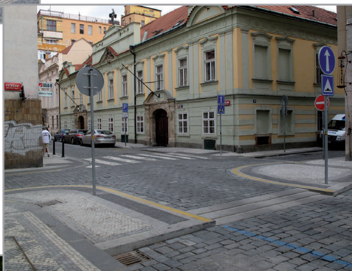
Stavební úpravy křižovatky Ostrovní x Voršilská – rozšíření nároží, zkrácení přechodů, zvednutí plochy křižovatky (ZŠ sv. Vojtěch projekt v r. 2007, realizace 2012)
