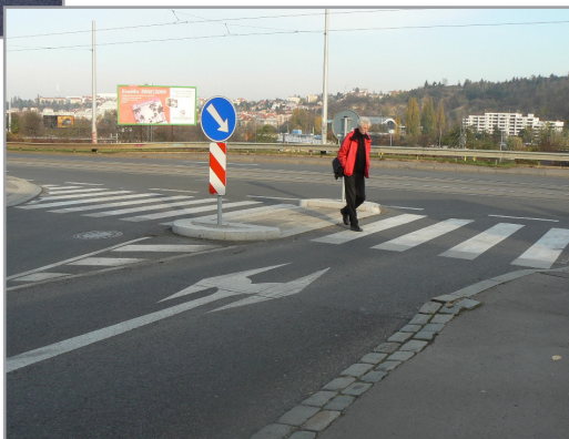
Dělicí ostrůvek přes ul. Křížová (Speciální ZŠ pro žáky se specifickými poruchami chování Zlichov, projekt v r. 2007, realizace 2008)
